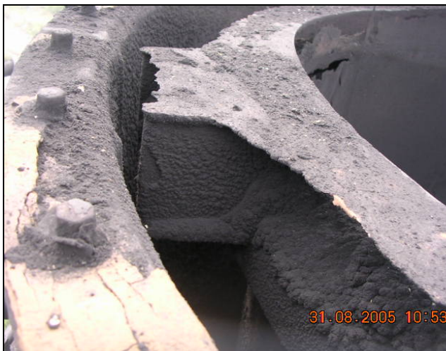
Slika 3. Spoljašnji i unutrašnji plašt na vrhu dimnjaka
